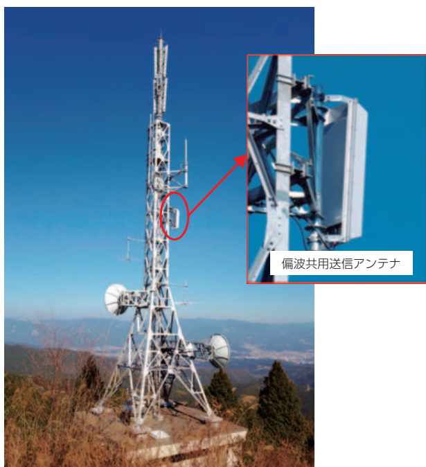
写真1 人吉実験試験局の外観
