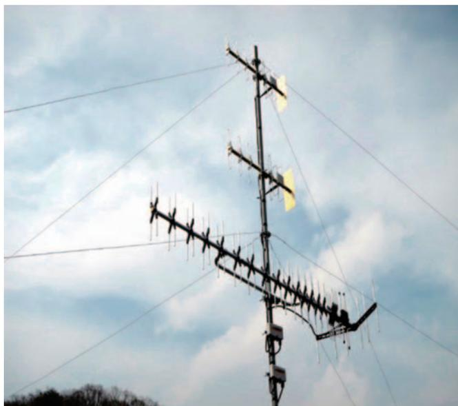
写真1 絶対難視世帯へのダイバーシティアンテナによる対策例
