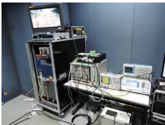
写真2 受信側の制御部、映像デコーダー、モニターの設置状況
