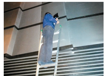
写真8 IRラジエーター設置作業
