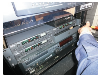
写真7 送信機設置作業(機器室)
